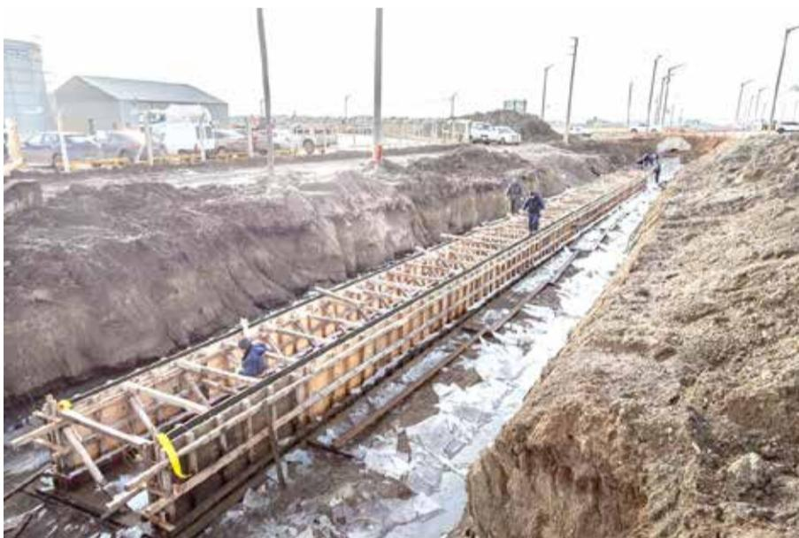
El Municipio de Río Grande comenzó con las tareas de construcción en la obra de entubado del canal Islas Malvinas, consistentes en movimientos de suelo, armado de estructuras de acero y posterior colado de hormigón, lo cual permitirá captar el agua de los pluviales de la zona, evitando anegamientos. En un primer tramo, los trabajos se extenderán desde la calle Punta Popper del B° Malvinas
